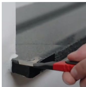
Поставување на парчето со креп трака и отстранување на лепак
