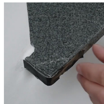
Отстранување на креп трака после 24 часа
