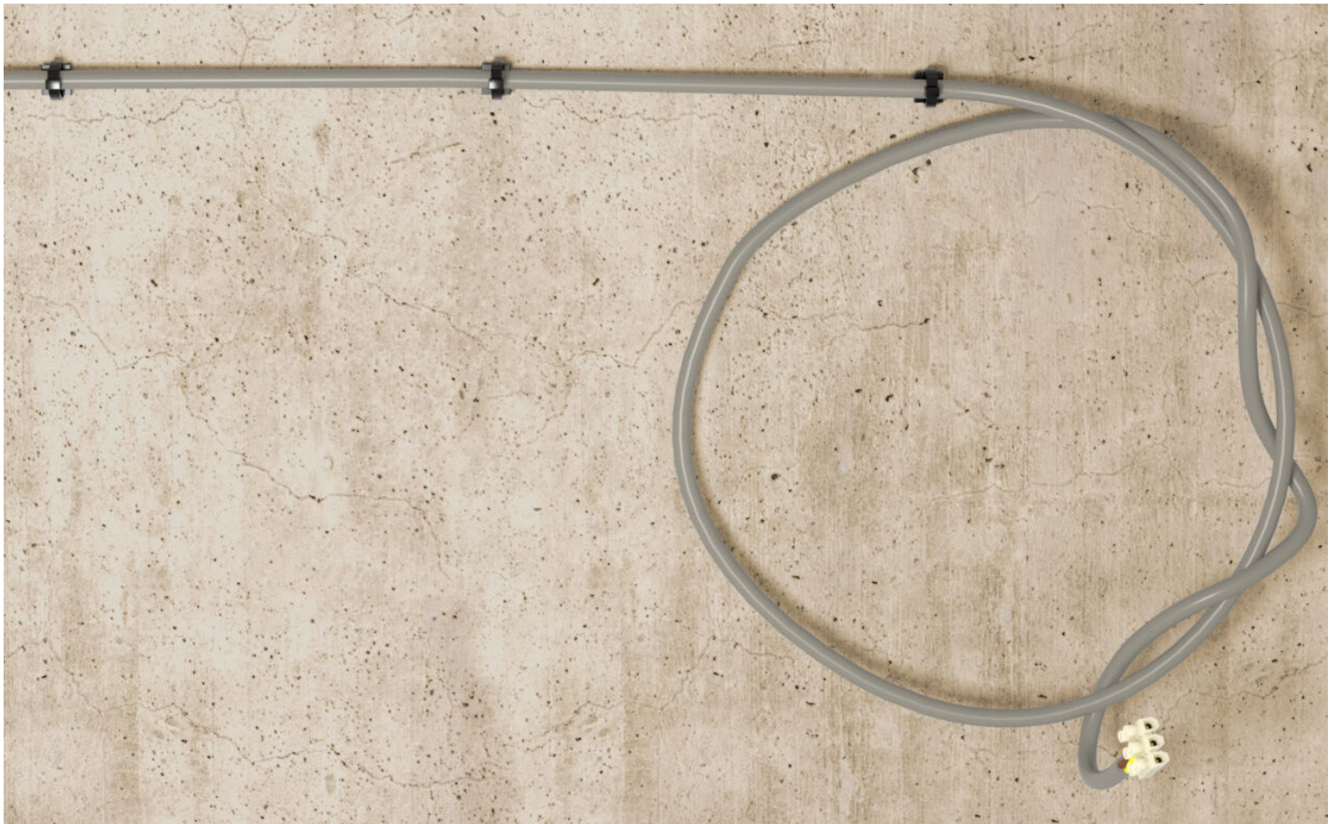
Позиционирање на каблите во стегата
