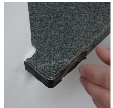
Отстранување на креп трака после 24 часа
