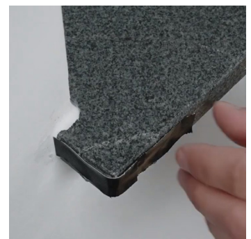
Отстранување на креп трака после 24 часа
